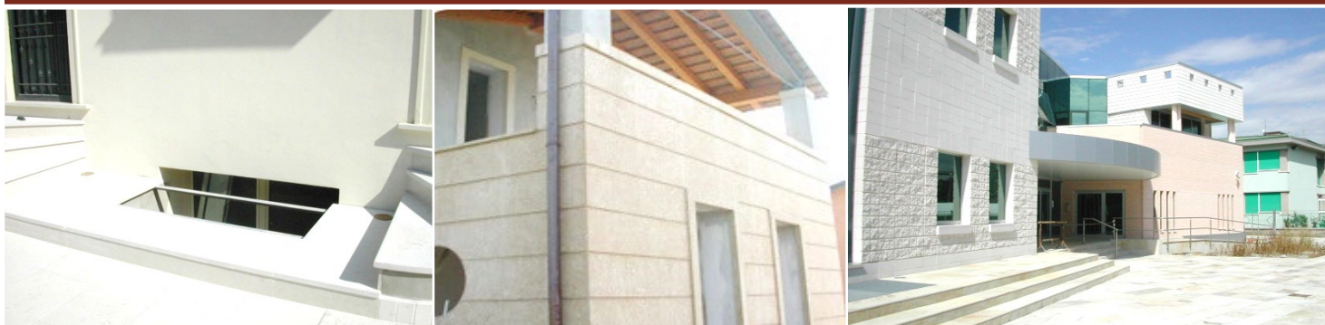
Aussenbereich Putz, Aussenbereich Sandstein und Putz
