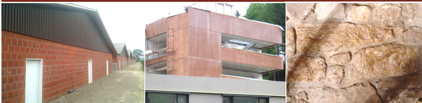
Landwirtschaftliche Bauten, Sichtbeton, Sandtseinkeller
